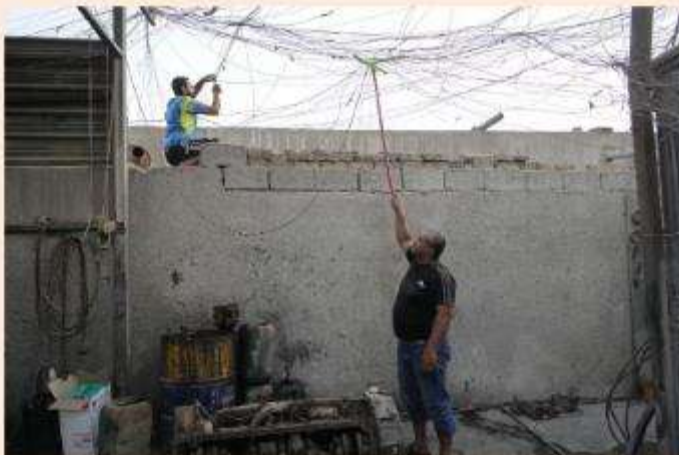
Ben elektricien in Bagoed sluit een dieselgenerator aan. In het Midden-Oosten zijn door problemen met het stroomnet veel generators. Foto: AP Photo / Hani Mizan
